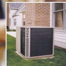
Bombas de calor
